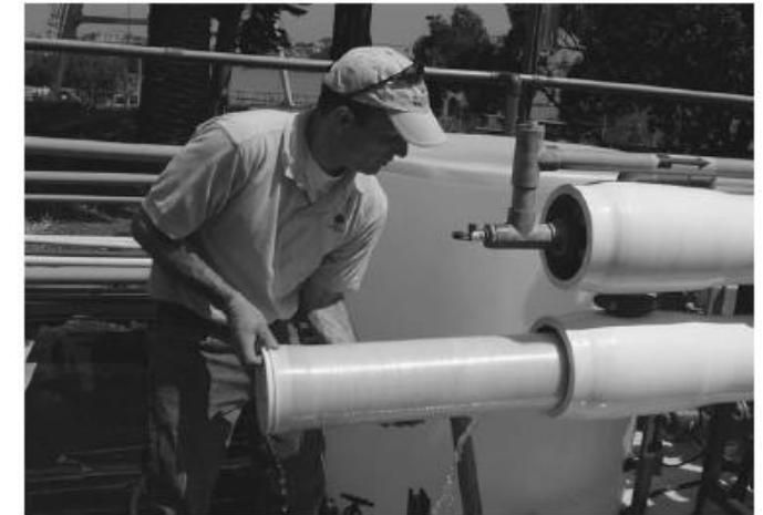
Instalación de Membranas
