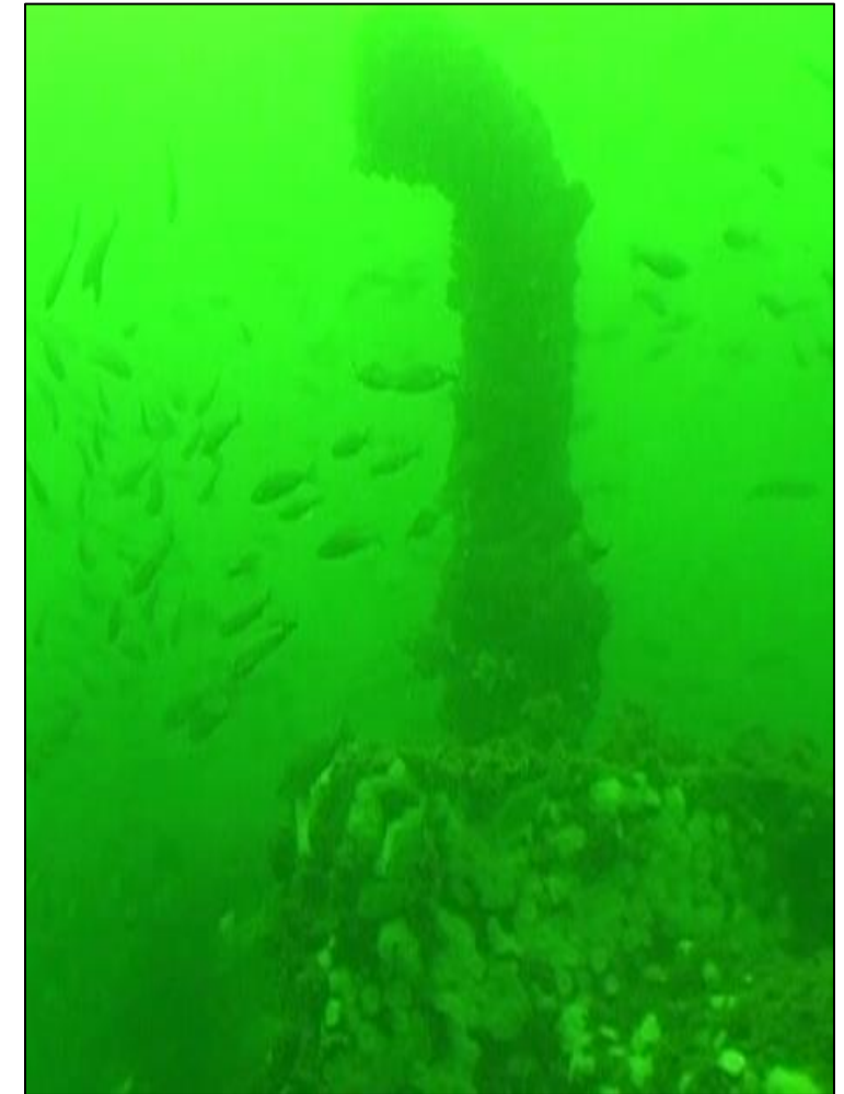
Difusor Desaladora Norte
