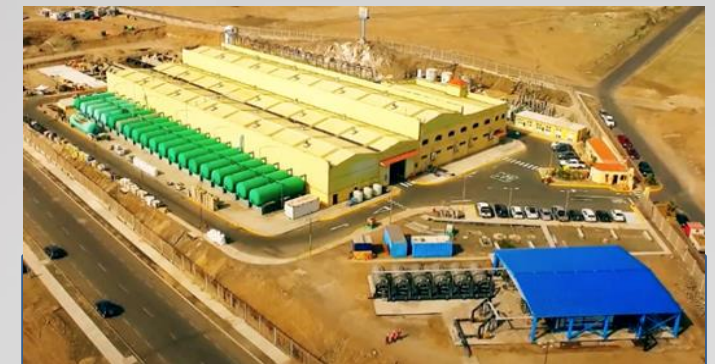
DESALADORA NORTE (PDN)
